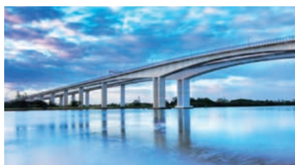
桥梁的劣化监测
