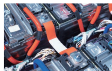
蓄电池母线的焊接电阻
